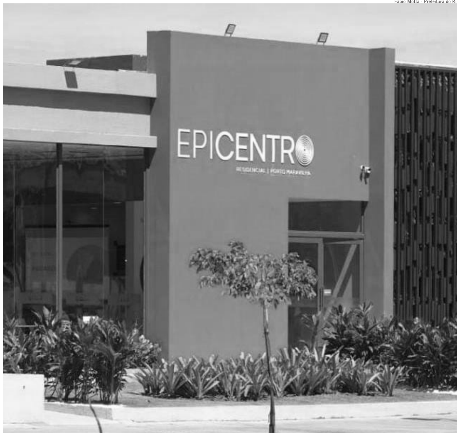
O empreendimento residencial Epicentro terá 954 apartamentos, divididos em duas torres de 28 andares, além de lojas no térreo voltadas para a rua
