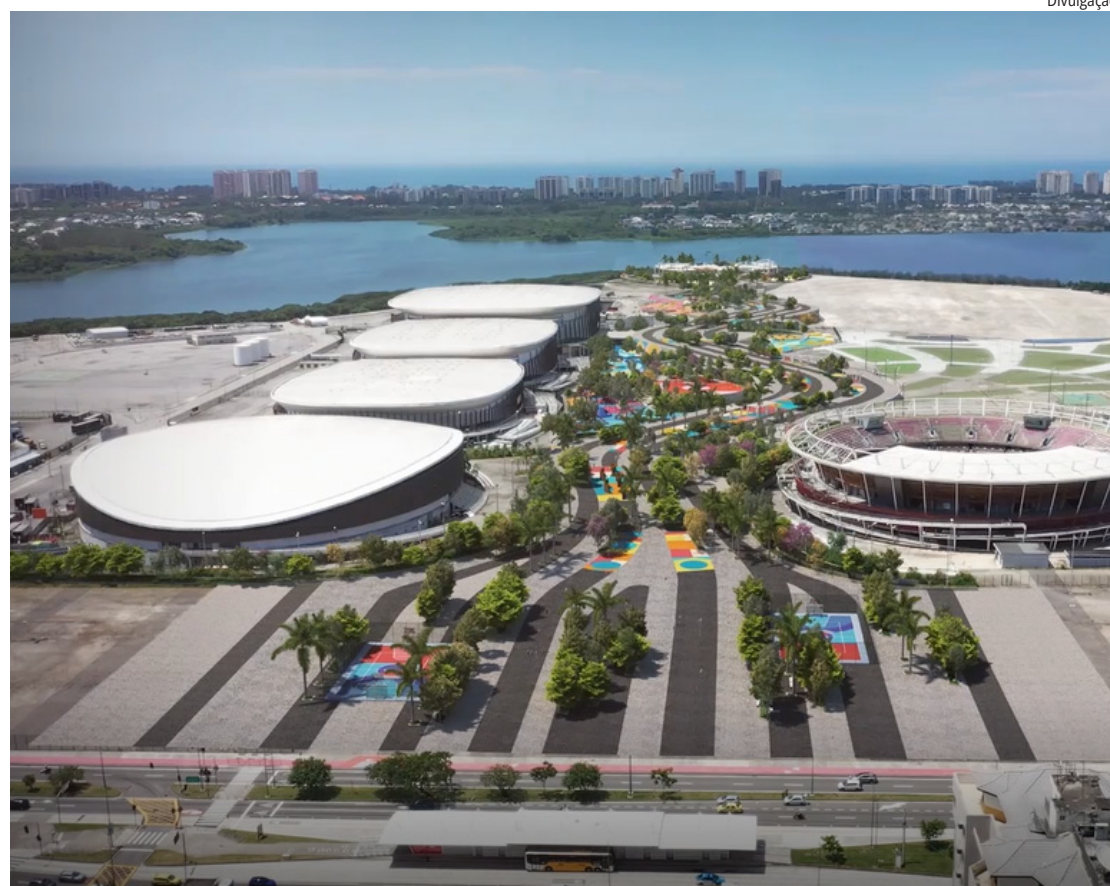
O espaço por onde passaram atletas, uma área de 36 mil metros quadrados, vai ser transformado em um parque público
